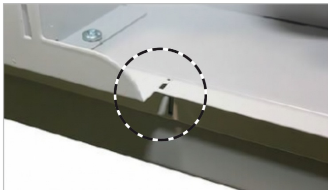
Abb. 3: Ausbrechkante an der hinteren Abdeckung
